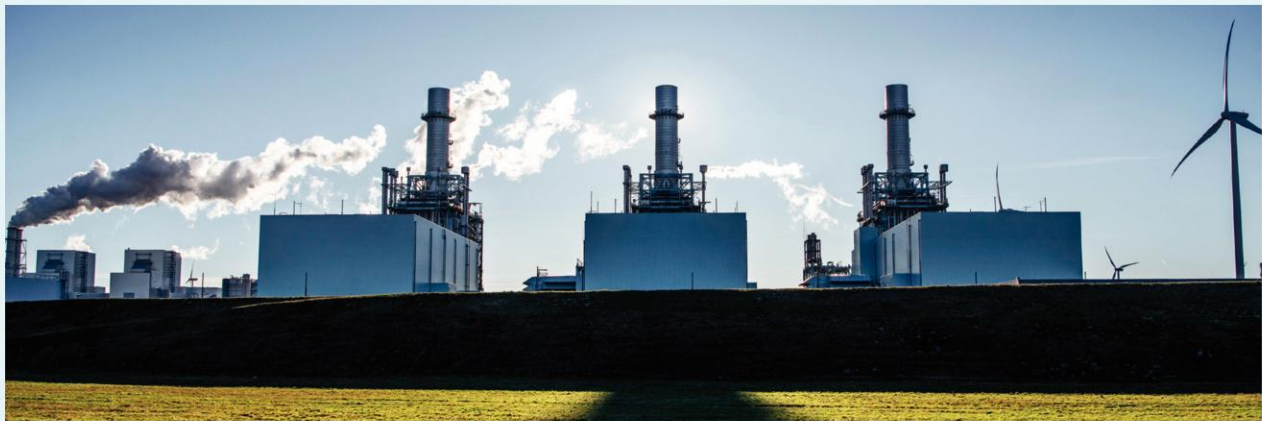
18.29 De Magnumcentrale in de Eemshaven met drie STEG-eenheden
