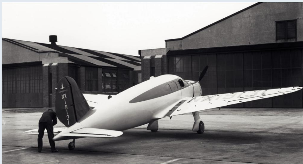
12.61 Buteendizuuranhydride is een belangrijke grondstof voor de productie van glasvezelversterkte plastics. Dit vliegtuig, de Fairchild F-46, was waarschijnlijk het eerste vliegtuig dat gebruikmaakte van deze vorm van plastic.
