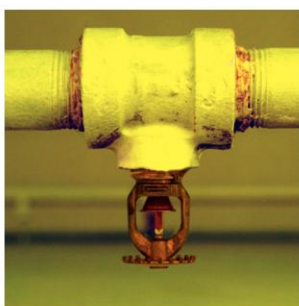
11.27 Door het lage smeltpunt wordt bismut gebruikt in woodsmetaal, een legering van bismut, lood, tin en cadmium, die in sprinklerinstallaties zit als smeltzekering.
