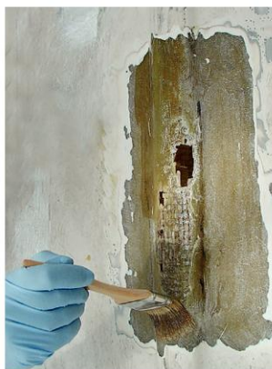
11.33 Aceton wordt gebruikt om beschadigd polyester te ontvetten voor een reparatie, zoals hier de zijkant van een zeilboot.
