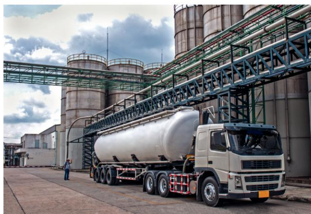
11.35 Bleekloog moet vanwege zijn sterk oxiderende werking in pvc opslagtanks worden vervoerd. De opslagtanks zijn aan de buitenkant verstevigd met een glasvezelversterkte polyester.
