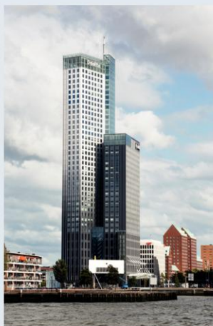
14.58 De Maastoren in Rotterdam wordt gekoeld met rivierwater.
