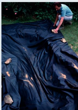
12.60 Het is nog niet eenvoudig om een vijver aan te leggen. Voor het verlijmen van het vijverfolie kun je tetrahydrofuran gebruiken.
