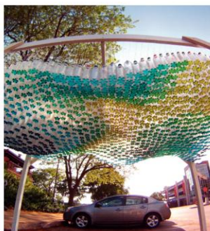
13.11a Deze carport is gemaakt van petflessen.
