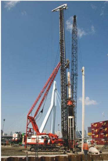
8.10 Een heimachine slaat lange palen in de grond.
